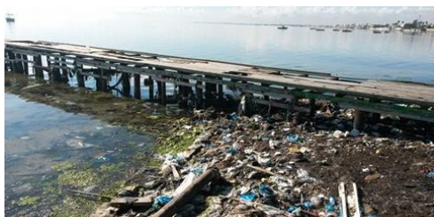
Figure n°4 : La passerelle délaissée
