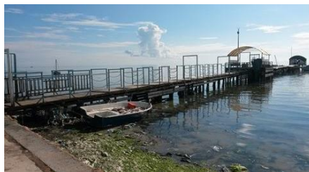
Figure n°5 : La passerelle récente
